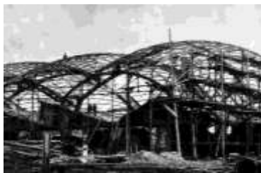
Монтаж конструкции перекрытий
