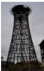
Водонапорная башня на территории Выксунского металлургического завода.
